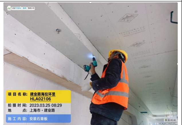
电动螺丝刀---代替人工快速完成安装
