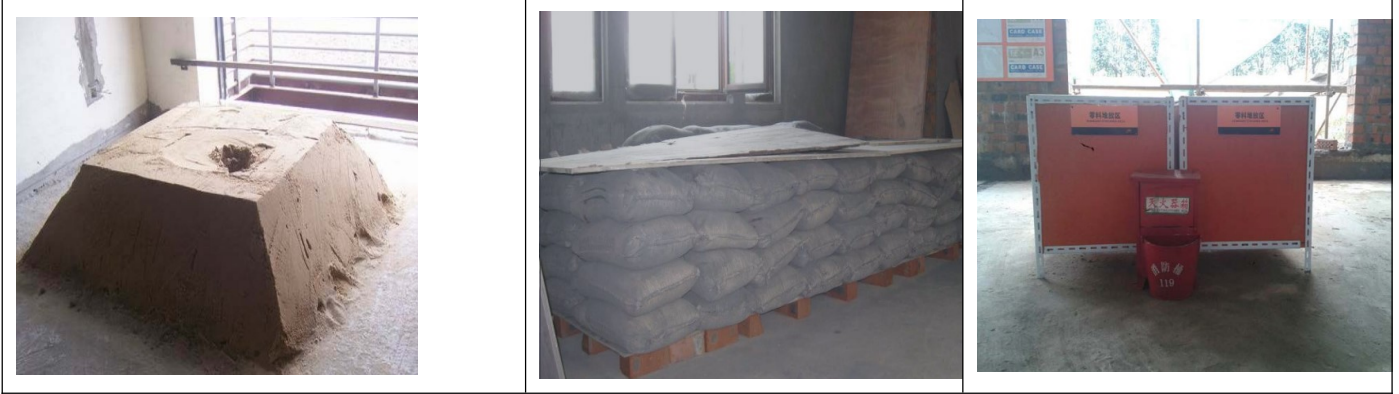
材料堆放及工完场清
