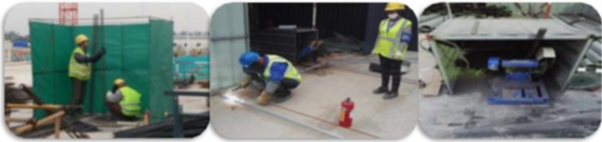
动火作业需要备灭火器和监火员监护及弧光棚
