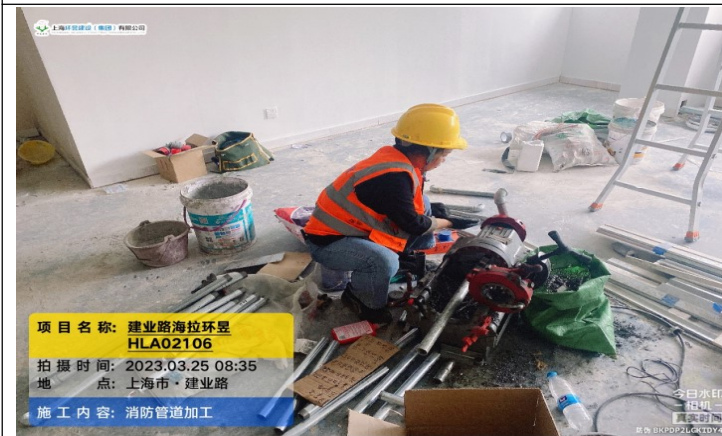
切割机---辅助人力完成管道切割
